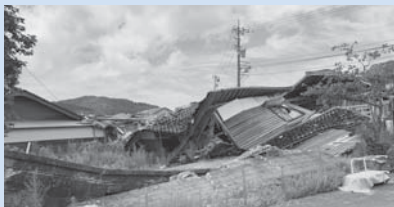
倒壊した家屋
